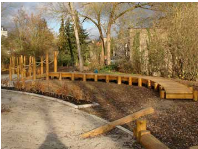
Bau von Pfählen auf dem Spielplatz „Am Brill“ Construction d'un pilotis à l'aire de jeux «Am Brill»
